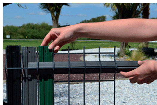
Glisser le profil en forme de «V» afin de bloquer les lamelles
