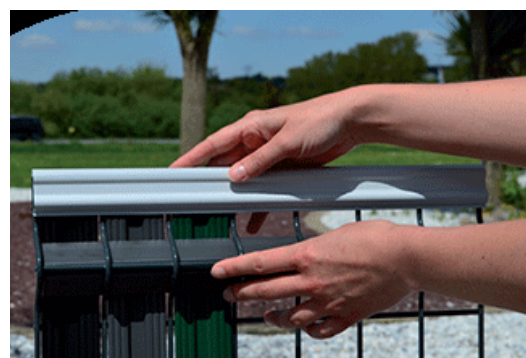
Glisser le profil de finition en forme de «U»
